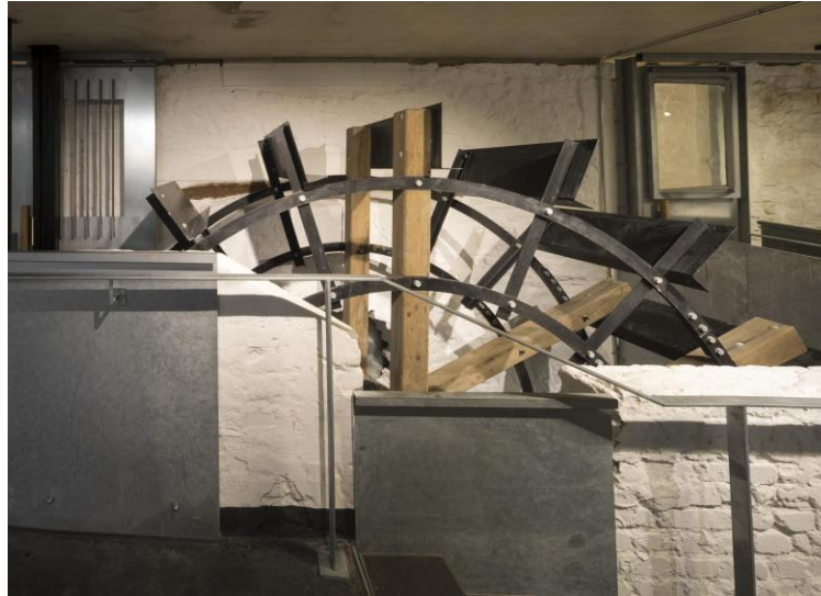
Mühlenrad mit Kanal – unbeheizter kalter Bereich
