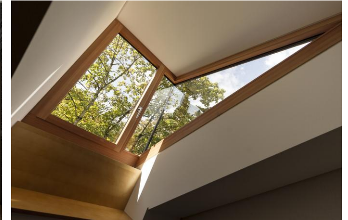
Neue Dachgaube zur besseren Belichtung
