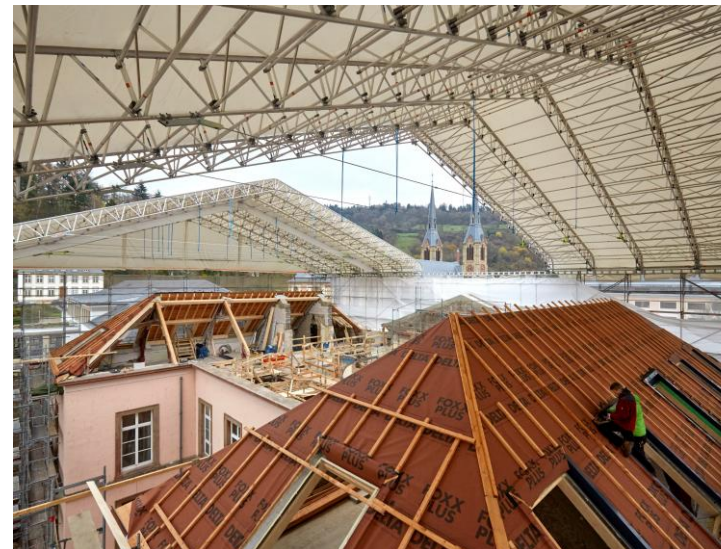
Wie den Bestand schützen bei Erneuerung des Daches
