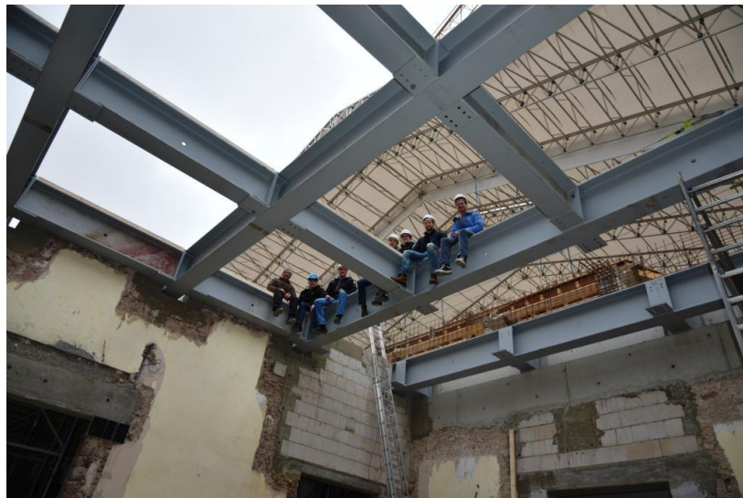
Neues Dachgeschoss entsteht über dem Sitzungssaal Verbesserung der Gebäudehülle zu beheiztem Volumen
