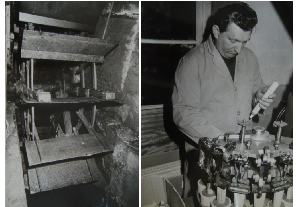
Historisches Foto des Mühlenrades hilfreich für die Rekonstruktion des neuen Mühlenrades und Herr Fior bei der Arbeit
