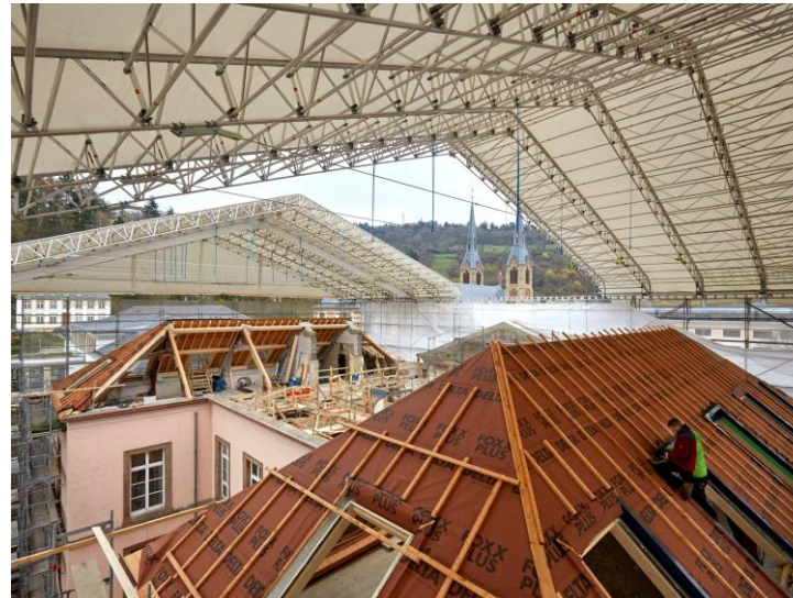
Wie den Bestand schützen bei Erneuerung des Daches
