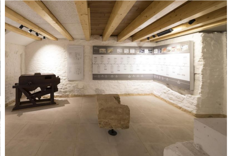
Übergang gedämmter Bereich zu unbeheiztem Bereich im Deckenfeld
